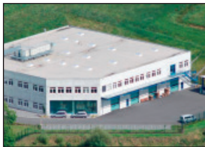
Im Firmengebäude ist durchgehend energieeffiziente Technik eingesetzt, z.B. moderne Lüftungsanlage, automatische Lichtsteuerung etc.
