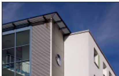
Sanierte Gebäudehülle am Peter-Hille-Weg 11
